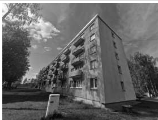
Dzīvojamā māja Vienības ielā 7
